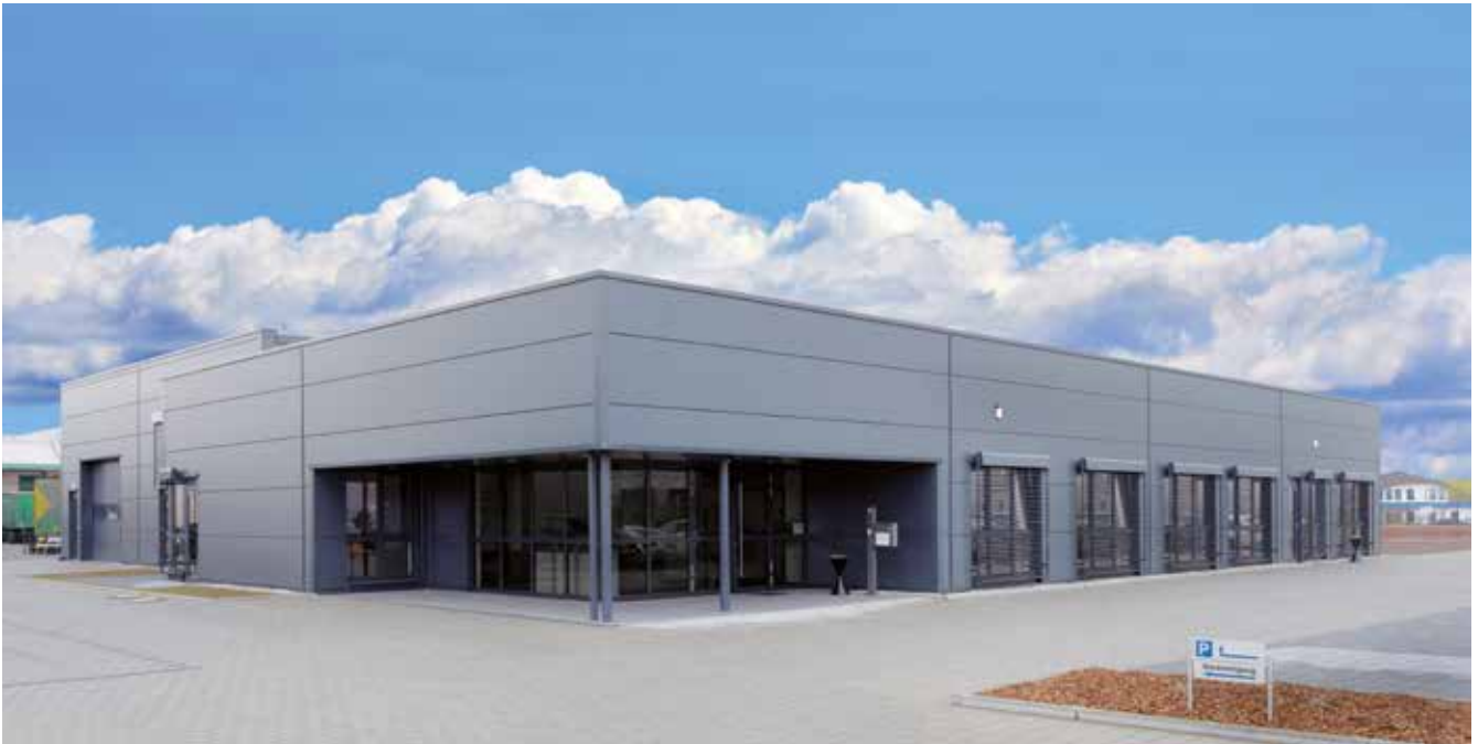
Das neu errichtete Betriebsgebäude der DTS wurde von der ISB mit Bürgschaften und Zuschüssen unterstützt.
