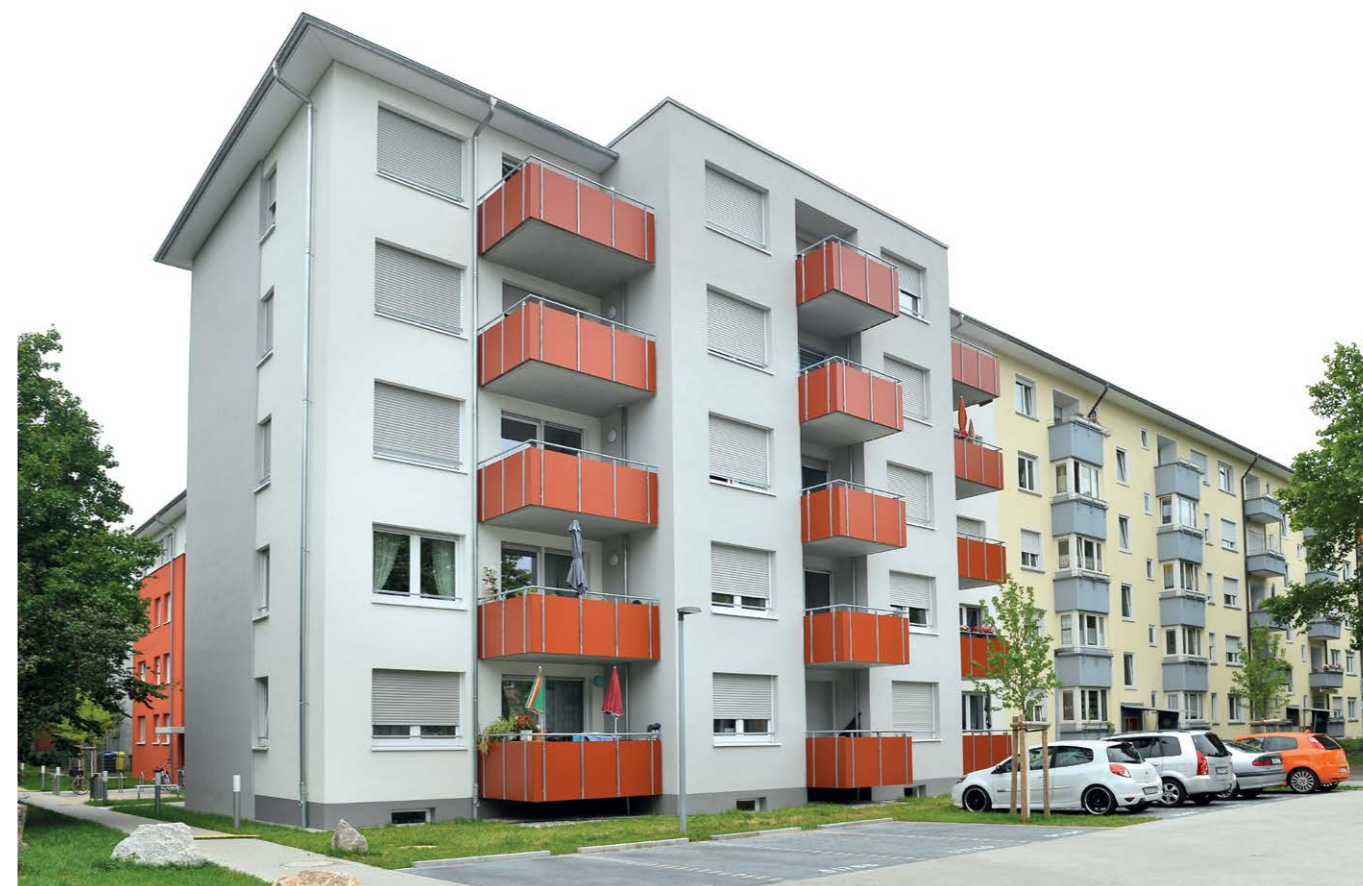
Der Neubau am Rande der Valentin-Bauer-Siedlung in Ludwigshafen
