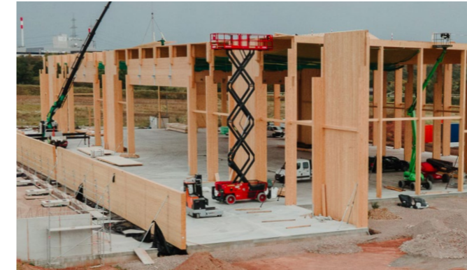
Rohbau in Holz: Hier entsteht gerade die Hightech-Fabrik
