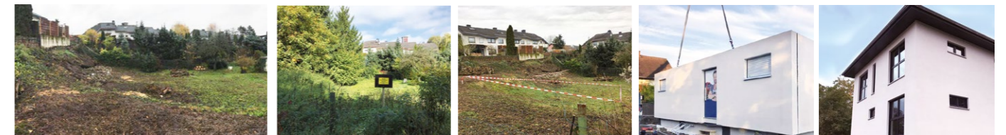
Schritt für Schritt zum eigenen Haus: Zuerst war das Grundstück, mittlerweile steht der Rohbau – bald wollen die Stamms einziehen.
